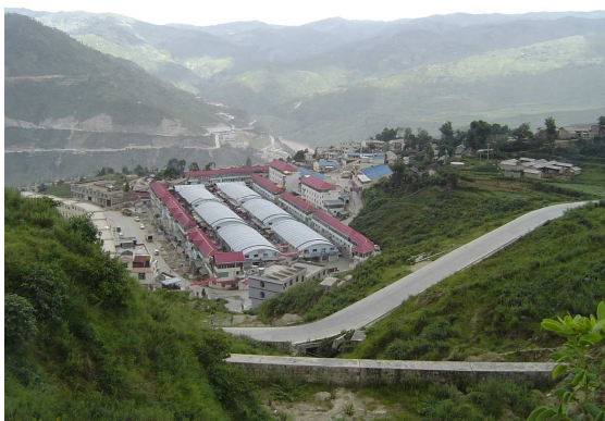
B-11: „Neues Dorf“ Xiaowan-Damm
