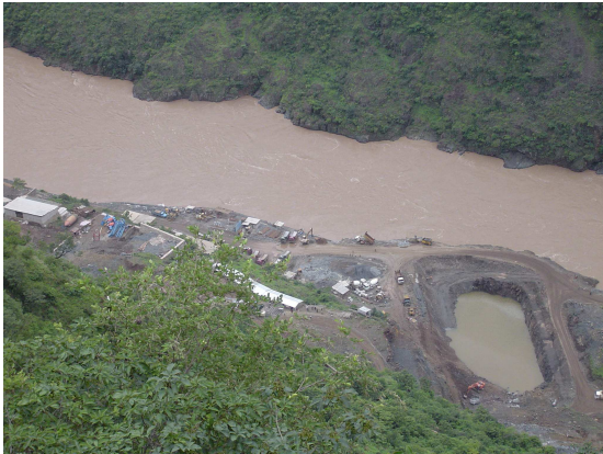
B-1: Gebiet des Dachaoshan-Dammes
